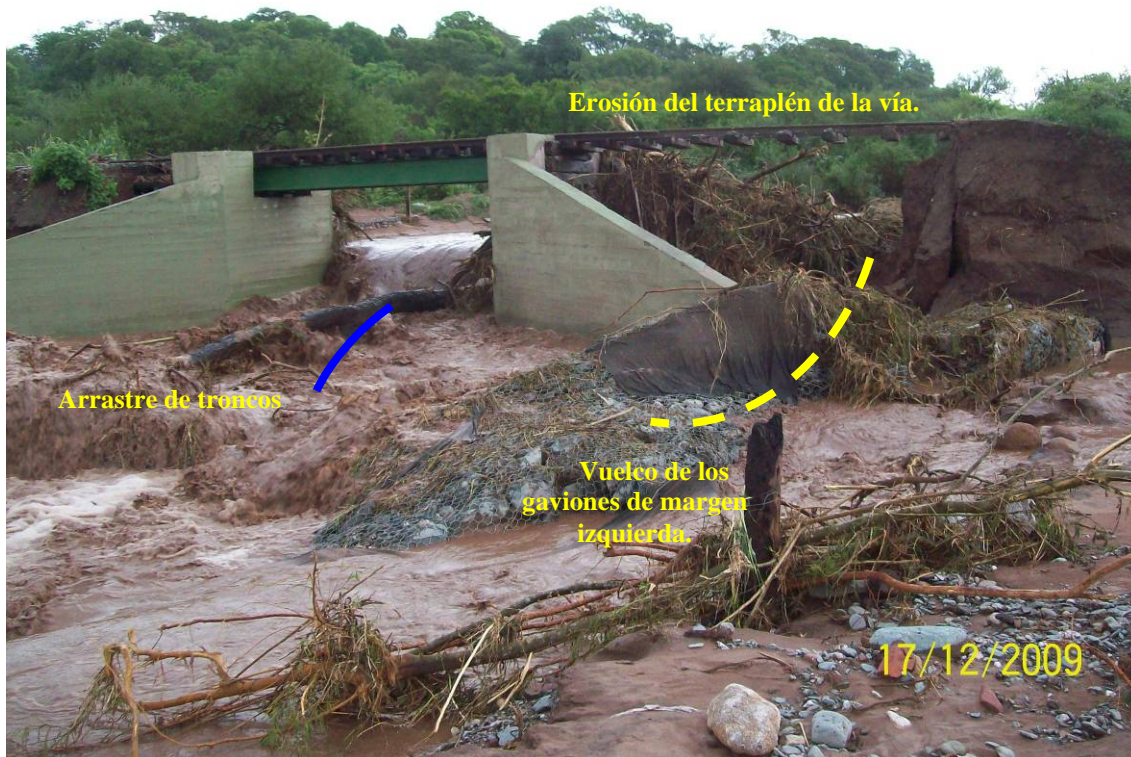
Figura 9: Defensas sobre margen izquierda. Vista desde aguas abajo de la alcantarilla. Arrastre de troncos en el torrente.
